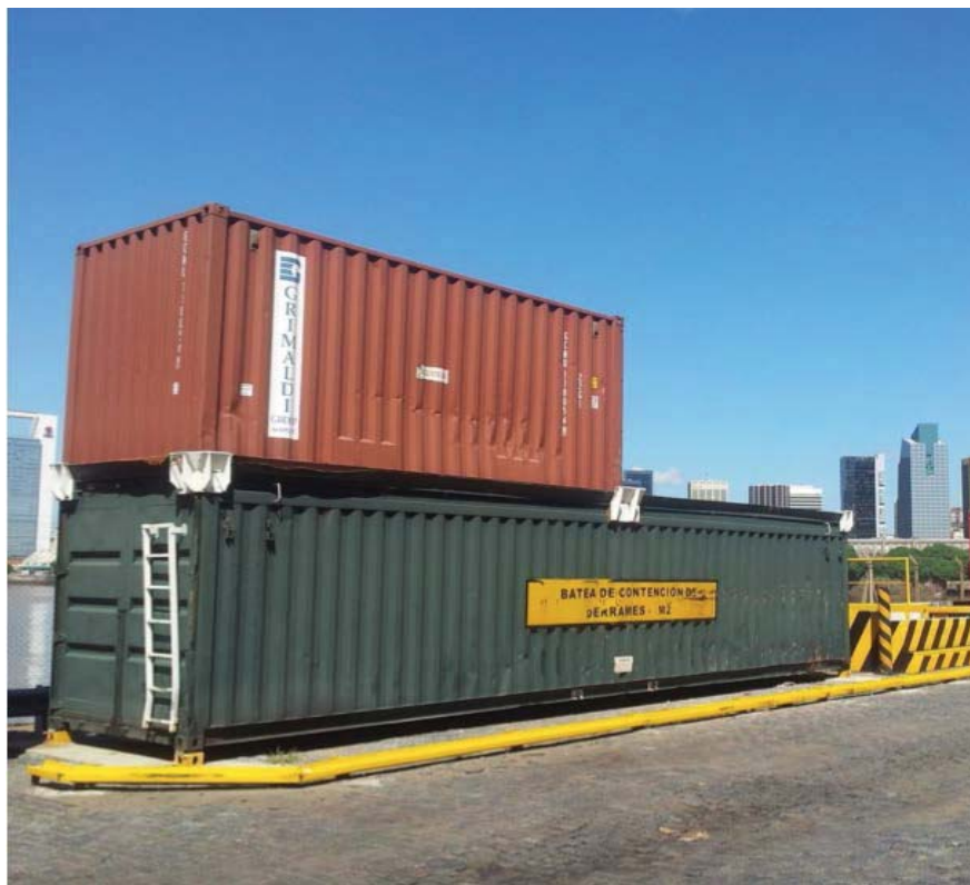
Foto 9: Modelo de dique de contenção fixo adaptado com contêiner usado. Observar condições inadequadas para acesso.
