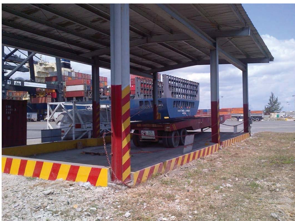
Foto 12: Modelo de dique de contenção fixo com cobertura fixa e pequena capacidade de contenção.
