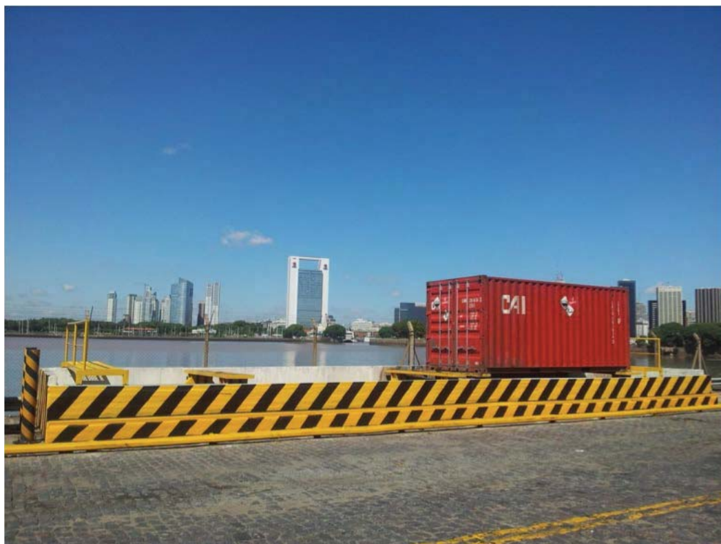
Foto 10: Modelo de dique de contenção fixo em concreto. Observar plataformas para aproximação e abertura dos contêineres.
